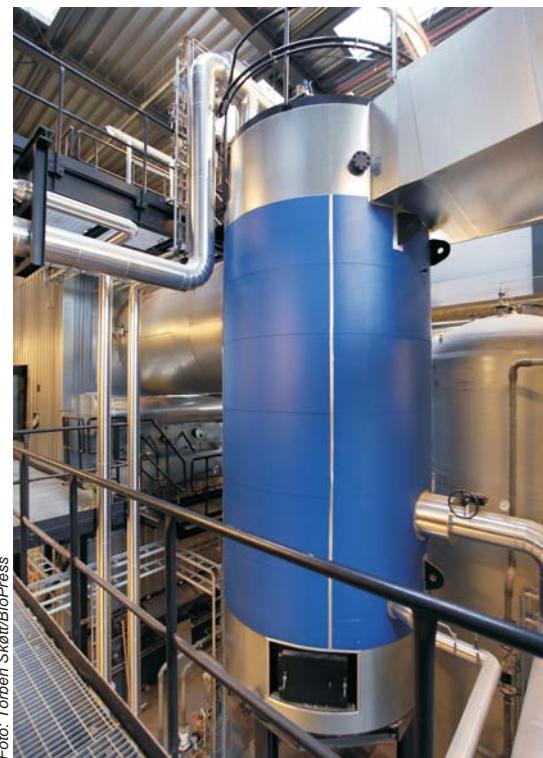
Kedlen, hvor halvdelen af energien omsættes til varmt vand. Den anden halvdel af energien tages ud i et røggaskondenseringsanlæg, hvor røgen køles ned til omkring 40 grader, inden den ryger ud gennem skorstenen.
