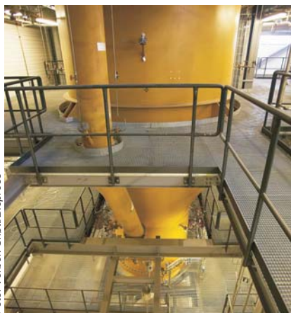
Forgasseren, hvor træpiller omsættes til gas, der anvendes til motordrift.
