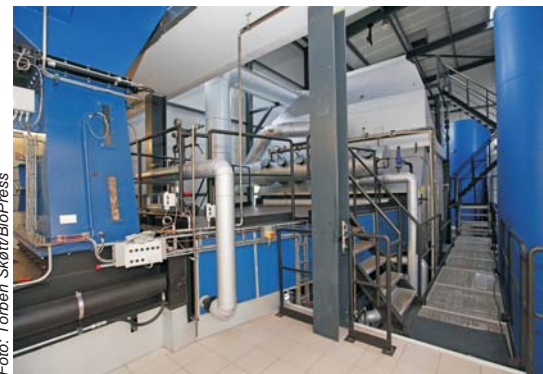
Et kig ind i maskinhallen med det nederste af ovnen til venstre på billedet. Bagerst til højre ses kedlen.
